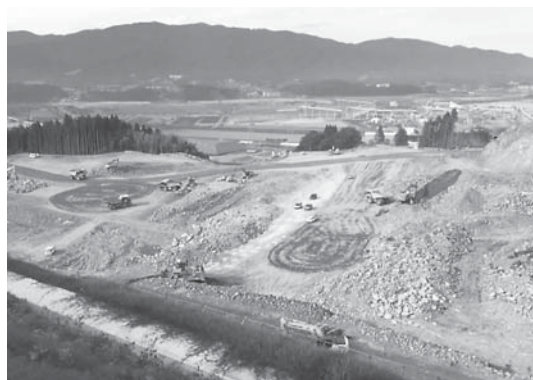
山を削り土砂を住宅造成に（陸前高田市）
