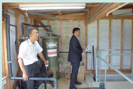
生ゴミ等をメタン発酵させ発生するメタンガスで発電を行い、農業ハウスの電力と暖房として利用する「循環型バイオマスエネルギー農業利用システム」
